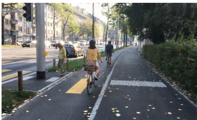
Anwendungsfall in Bern: Die mehrspurige Fahrbahn im Ostring ist nicht geeignet für eine attraktive und sichere Veloführung. Der Veloverkehr ist auf einem baulich angesetzten Radweg hinter der strassenbegleitenden Baumreihe angeordnet und wird vor seitlichen Einmündungen an die Fahrbahn herangeführt.
