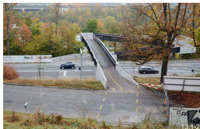
Fuss- und Velobrücke über die Tiefenastrasse in Bern.
