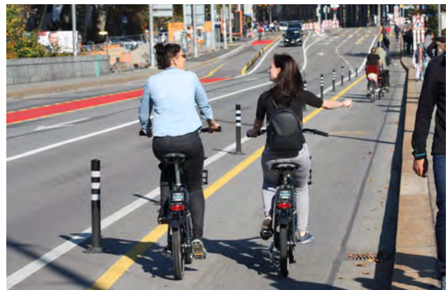
Aufgrund des ausgewiesenen Bedarfs wurde die Separierung des Veloverkehrs mit der Anordnung von Pollern als Sofortmassnahme umgesetzt.
