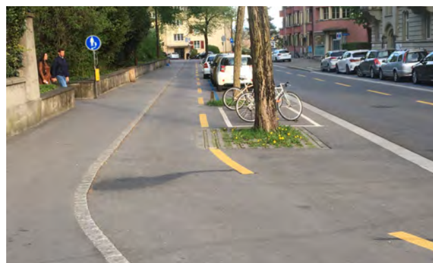
Anwendungsfall in Bern: Der Veloverkehr wird an der Sulgeneckstrasse auf einem Radweg hinter der Längsparkierung geführt. Dadurch entstehen keine Konflikte zwischen Velos und Parkierung.
