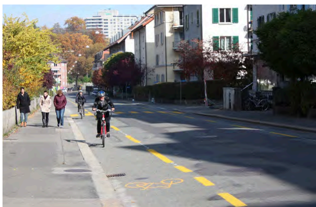
Kernfahrbahn anstelle Längsparkierung: Mehr Raum für den Veloverkehr, bessere Überholmöglichkeit für den ÖV. (Könizstrasse, Bern)
