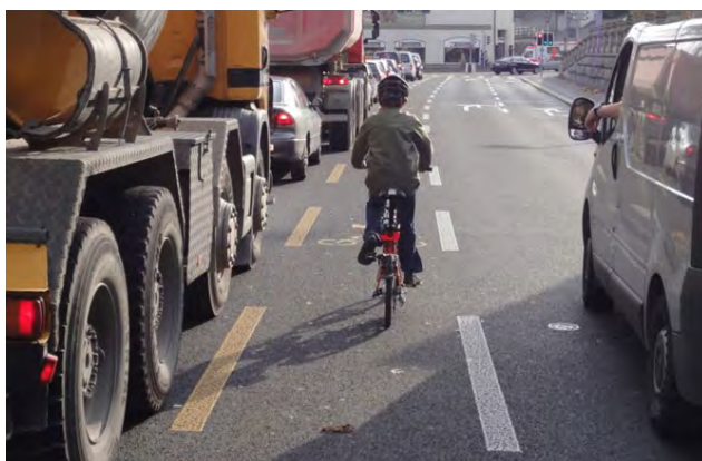
Radstreifen in der Mitte zweier Fahrstreifen des MIV sind bei mittleren und hohen Belastungen sowie bei erhöhtem Schwerverkehr- und ÖV-Anteil unangenehm (Bild: U. Walter).
