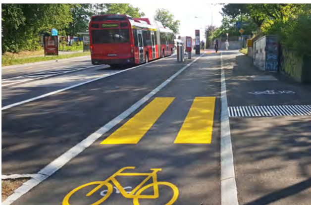
Neu gestaltete Haltestelle Dübystrasse, Bern: ausreichende Platzverhältnisse und Ausführung gemäss UHR (taktile Abgrenzung FG / Velo).
