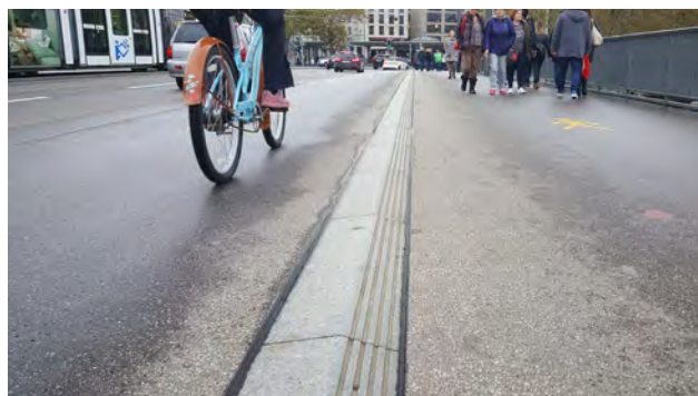
Trennung Fuss- und Veloverkehr Quaibrücke, Zürich
