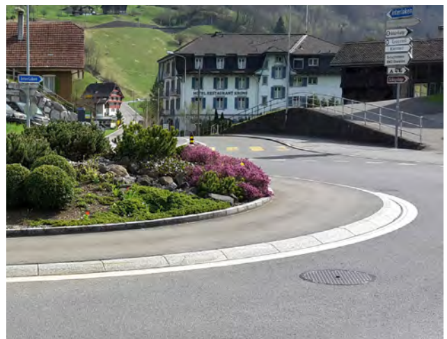
Der aufgeschüttete Innenring ist ein wichtiges Ausführungsdetail. Damit werden ein genügender Ablenkwinkel und in Folge dessen tiefe Geschwindigkeiten des motorisierten Verkehrs sichergestellt. (Bild: Jonas Zurschmiede).
