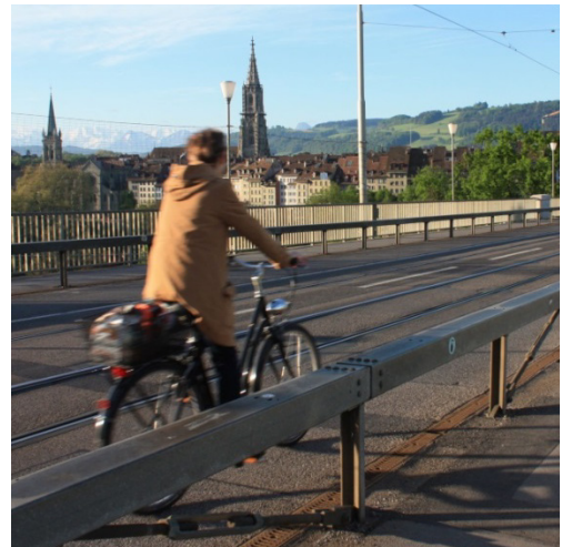
Kornhausbrücke in Bern
