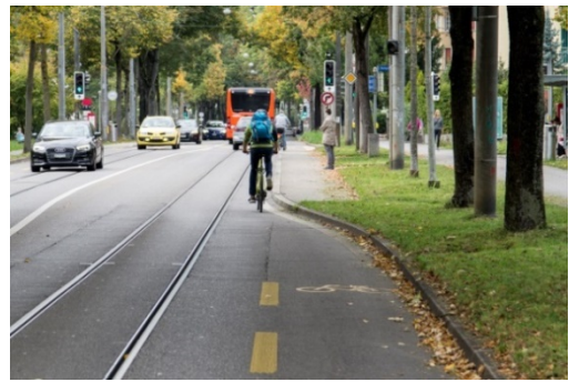
Problematisch: Kaphaltestelle auf einer Velohauptroute. Die Durchfahrt ist schmal und für ungeübte Velofahrende eine Herausforderung. Eine Umfahrungsmöglichkeit besteht nicht (Haltestelle Weltpostverein).
