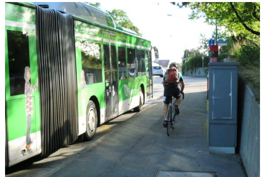
Haltestelle Dübystrasse: vor dem Umbau.
