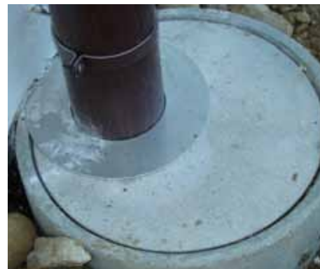
... und nach der Sicherung mit einfacher Alu-Manschette (Spenglerei)
