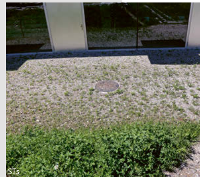
Fließender Übergang von Wiese zu befestigter Fläche (Weissenstein)
