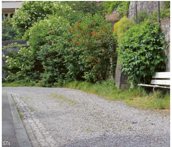
Unversiegelter Weg mit asphaltiertem Trottoir und gepflasterter Regenabflusssrinne (Länggasse)
