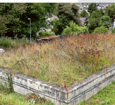
Herbstaspekt einer Blumenwiese auf einem begrüntem Garagendach mit mächtiger, modellierter Substratschicht (Felsenau)
