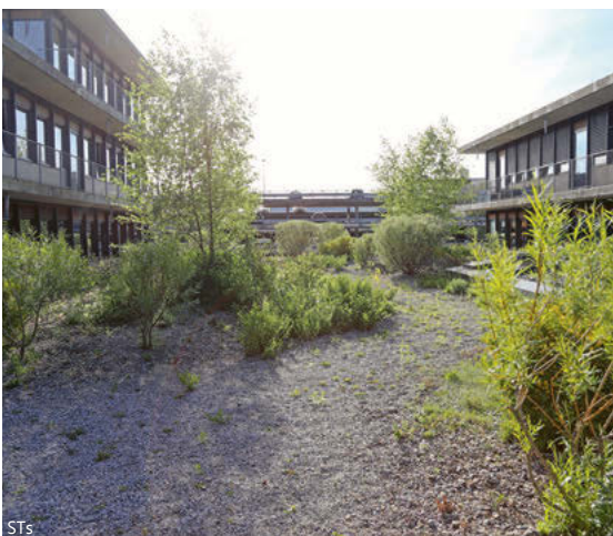
Naturnah begrünzte Dachterrasse (Zürich)
