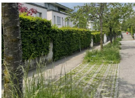
Abb. 27. Entsigelte Parkflächen im Traffeletweg (Bern, 2)
