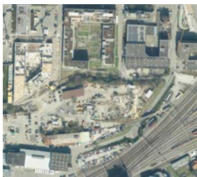
Abb. 78. Luftbild der Detailansicht
