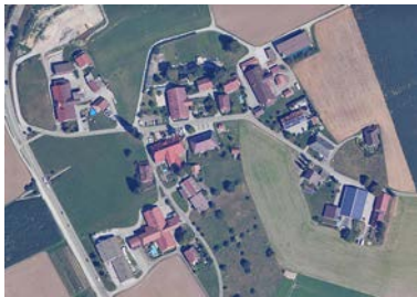
Abb. 66. Luftbild der Detailansicht
