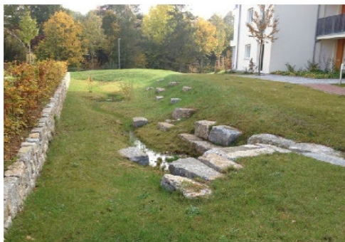
Wasserführender Graben im Stadtquartier Arkadien, Winnenden (Foto: Ramboll Studio Dreiseitl) Einzelmassnahme künstliche Wasserflächen (Quelle: http://www.kuras-projekt.de )
