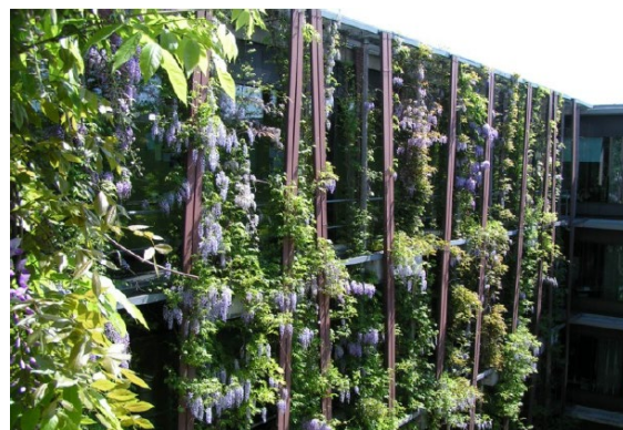
Systemgebundene Fassadenbegrünung in Kübeln, Institut für Physik in Berlin Adlershof (Foto: M. Schmidt); Sonderform mit Anstaubewässerung und Kletterhilfe
