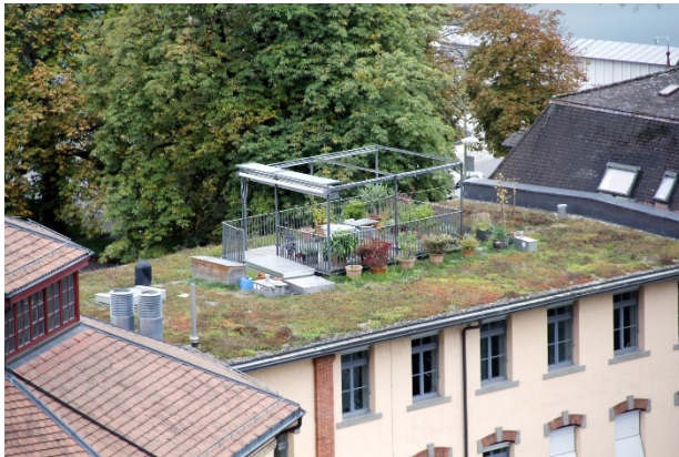
Dachbegrünung (Quelle: Stadt Bern)
