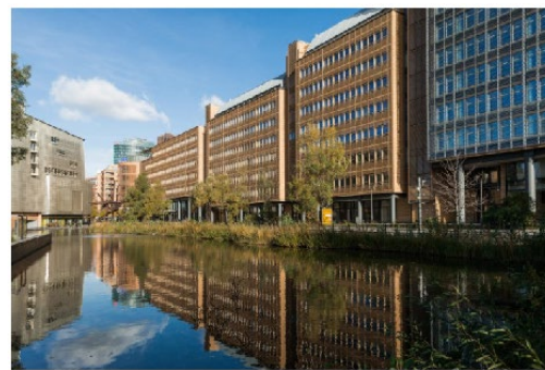
Künstliches Gewässer zur Aufnahme des Regenwassers am Potsdamer Platz, Berlin (Foto: Andreas Süß) Einzelmassnahme künstliche Wasserflächen (Quelle: http://www.kuras-projekt.de )
