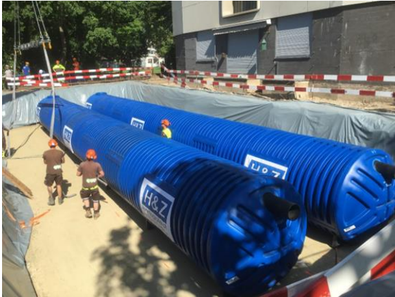
Montage Regenwassertanks 2022 (Quelle: SGB)
