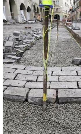
Rathausgasse nach neuer Materialisierung (links), Einbau Pflasterung auf Koffer (Quelle: SGB)
