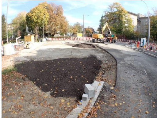
Einbau Substrat (Quelle: SGB)
