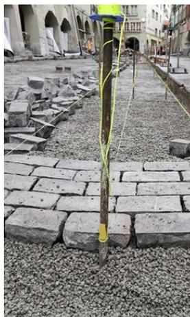
*Rathausgasse nach neuer Materialisierung (links), Einbau Pflästerung auf Koffer (Quelle: SGB)*
