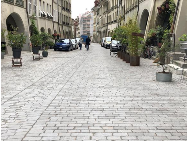
Rathausgasse nach neuer Materialisierung (links), Einbau Pflasterung auf Koffer (Quelle: SGB)
