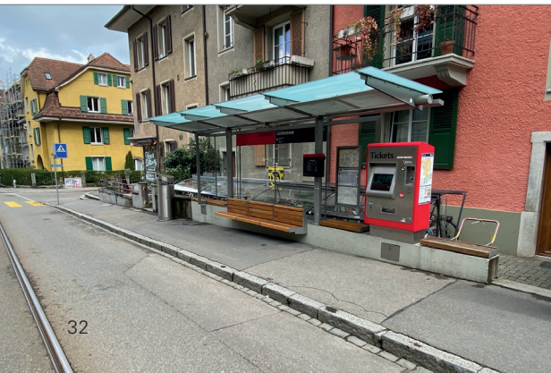
Alle Tramhaltestellen auf der Linie 6 ab der Effingerstrasse sind noch nicht hindernisfrei ausgestaltet. Das Bild zeigt die Haltestelle Cäcilienstrasse. Hier ist die Haltekante zu niedrig und zu weit von den Gleisen entfernt.
