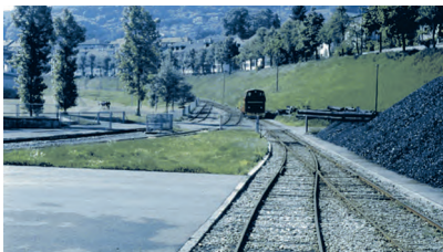
Gasbahngleise in Richtung Wabern
