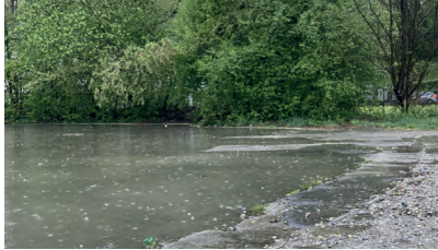
Fundament Gaskessel, mit bestehender Heckenstruktur
