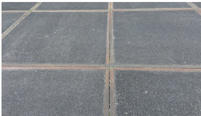
Betonplatten, mit sickerfähigen Fugen
