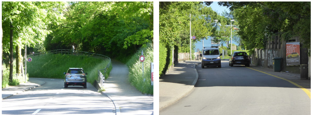
Abbildung 21: Abschnitte der Sandrainstrasse mit 5.0 m Querschnitt (links) und 6.0 m Querschnitt inkl. Gehwegmarkierung (rechts)
