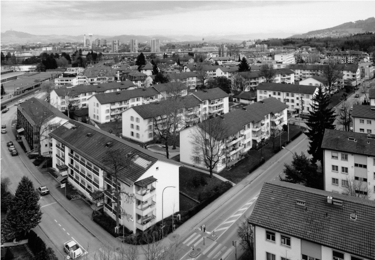
Abbildung 4: Siedlung Meienegg heute, Blick von Nord-Westen, Quelle: FAMBAU
