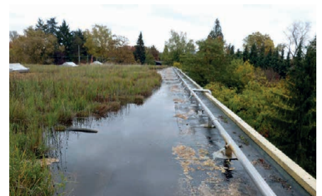
Mit einem Retentionsdach kann das Regenwasser zurückgehalten und verzögert abgegeben werden
