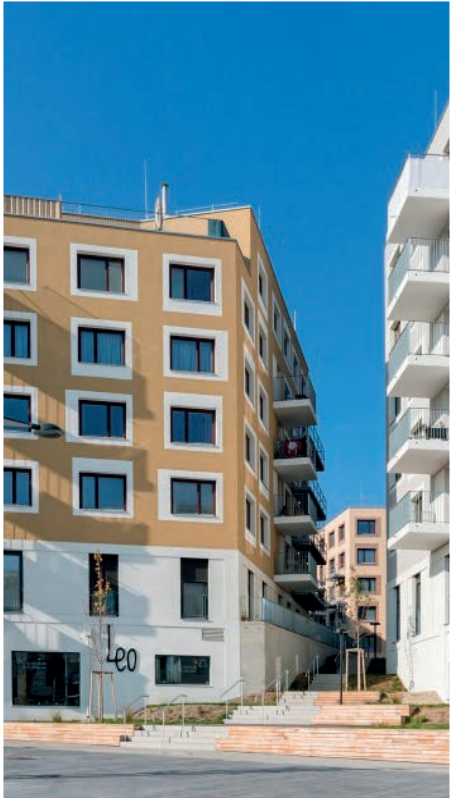
Zweigeschossiger Sockel, Aspern, Wien
