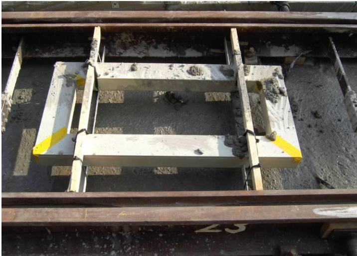
Abbildung 41: Ortungskreis (HFK-Spule) vor dem Betonieren.
