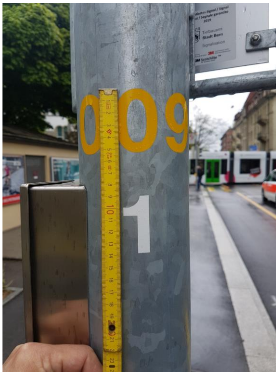
Abbildung 9: Beispiel Ausführung Mastnummerierung inkl. Knotennummer.
