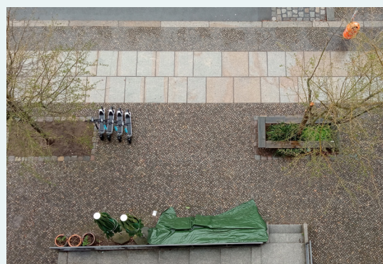
Strassenseitenraum in Berlin mit Gehbahn (weisse Betonplatten) und separater Fläche für den Aufenthalt und die Ausstattung.
