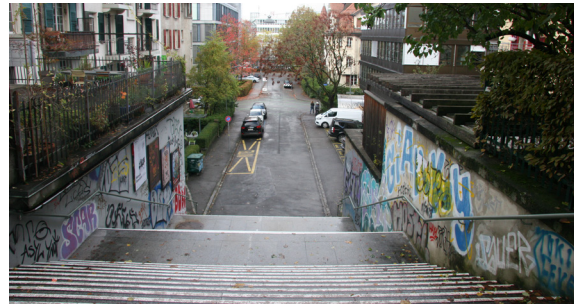
Visuelle Treppenmarkierung und Handläufe sind zwei Elemente eines hindernisfreien öffentlichen Raumes für Treppen an der Greyerzstrasse.
