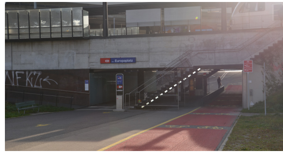
Unterführung beim Europaplatz mit getrennten Flächen.
