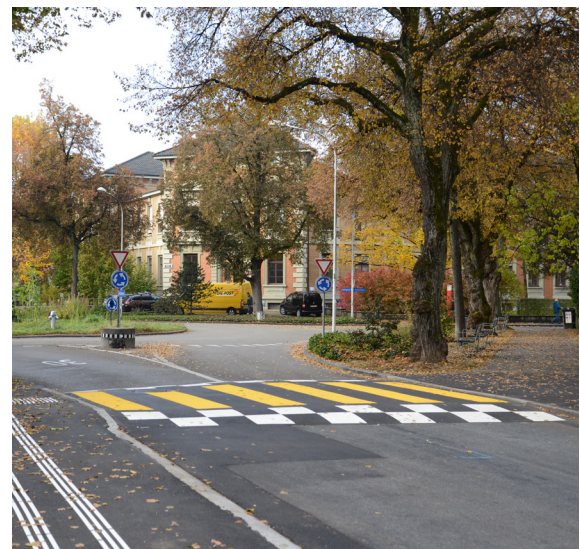
Fussgängerstreifen in Kombination mit Anhebung der Querungsstelle an der Bühlstrasse beim Bühlkreisel.
