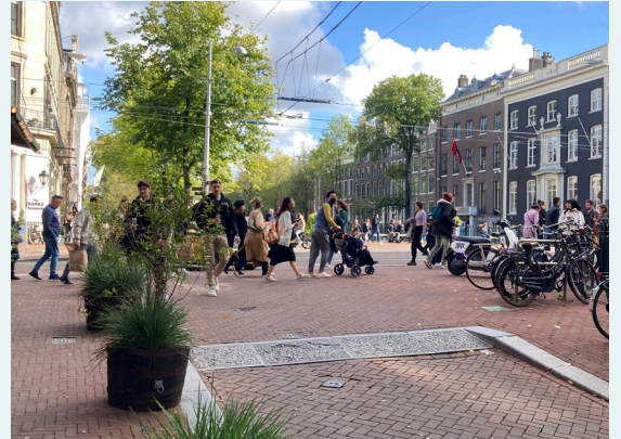
Sehr breite durchgängige Trottoirs über einmündende Strassen sind in der Niederlande Standard. Hier mit angenehmer Rampe, welche gut durch Velos befahren werden kann.
