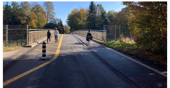
Sicherung des Fussgängerlängsstreifens mit einem Inselfosten
