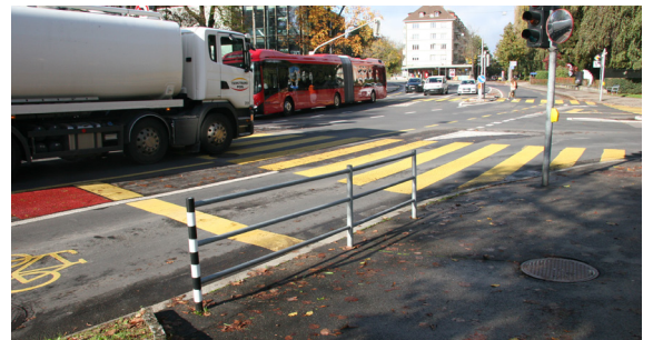
Geländer gemäss UHR an der Laubeggstrasse.
