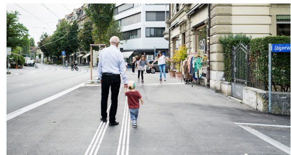
Durchgehendes Trottoir am Knoten Moserstrasse/Jägerweg mit Leitlinien.
