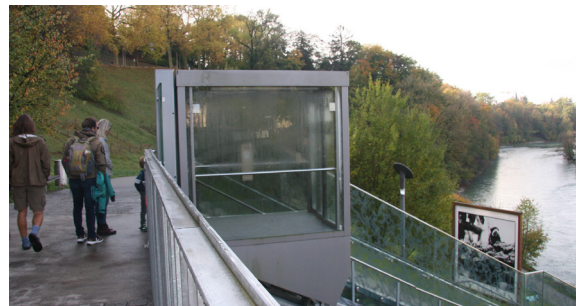
Der Schräglift ist eine hindernisfreie Ergänzung zur Treppe und zum steilen Weg.
