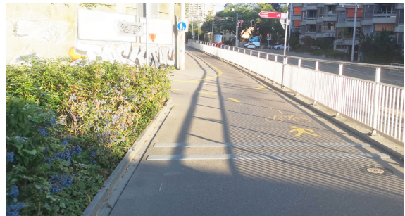
Kreuzung von nicht getrennten Fuss- und Radwegen an der Bernstrasse/ Bahnhöheweg
