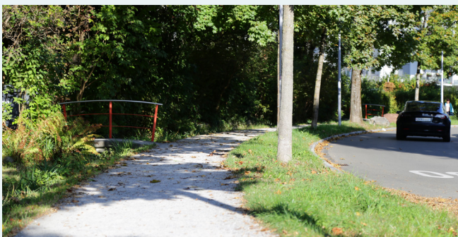
Einseitige Entsiegelung, In der Ey in Zürich.
