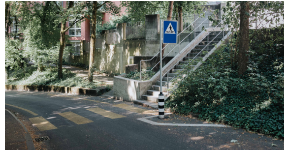
Markierte Einengung mit Wartebereich beim Fussgängerstreifen Sulgenrain.
