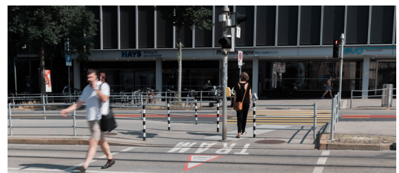
Um Personen bei der Tramhaltestelle Kocherpark zu schützen, wurden Umlaufsperrn errichtet.
