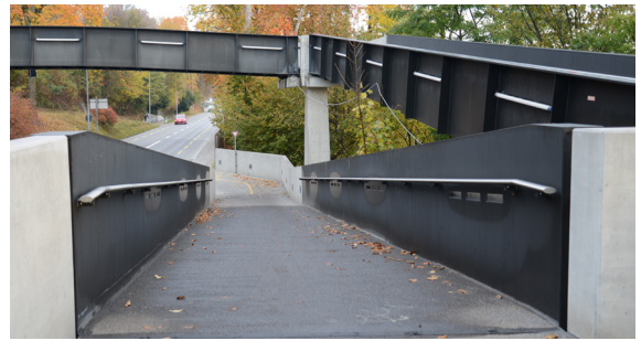
Rampe mit ca. 8\% Steigung, bei der Brückenverbindung Wildpark über die Tiefenastrasse
