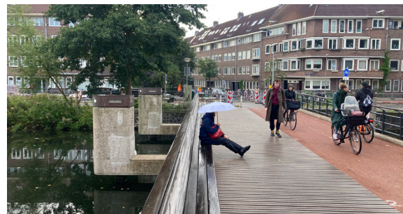
Beispiel einer Fuss-Velobrücke aus Amsterdam mit getrennter Infrastruktur und Sitzbank für den Aufenthalt.
