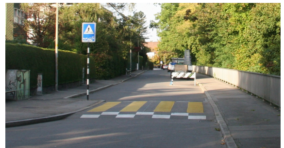
Kombination vertikalem Versatz und Fussgängerstreifen.
