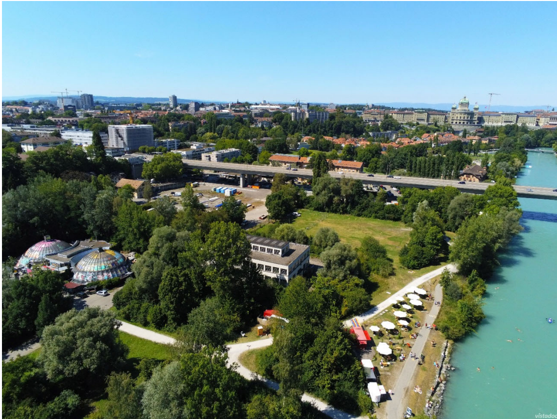
Gaswerkareal Bern, Richtung Norden
