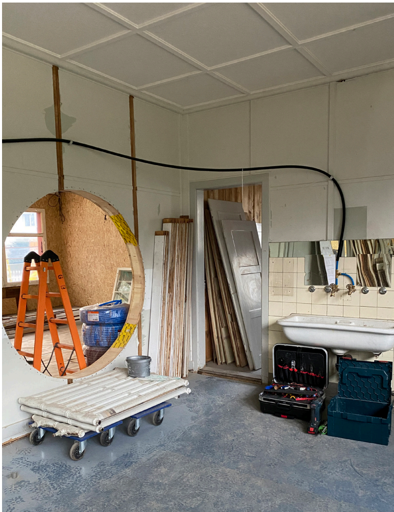
Arbeiten bei der Volksschule Elfenau
