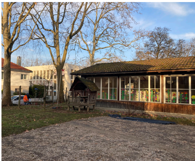
Kindergarten Efenau vor Gesamtanierung
