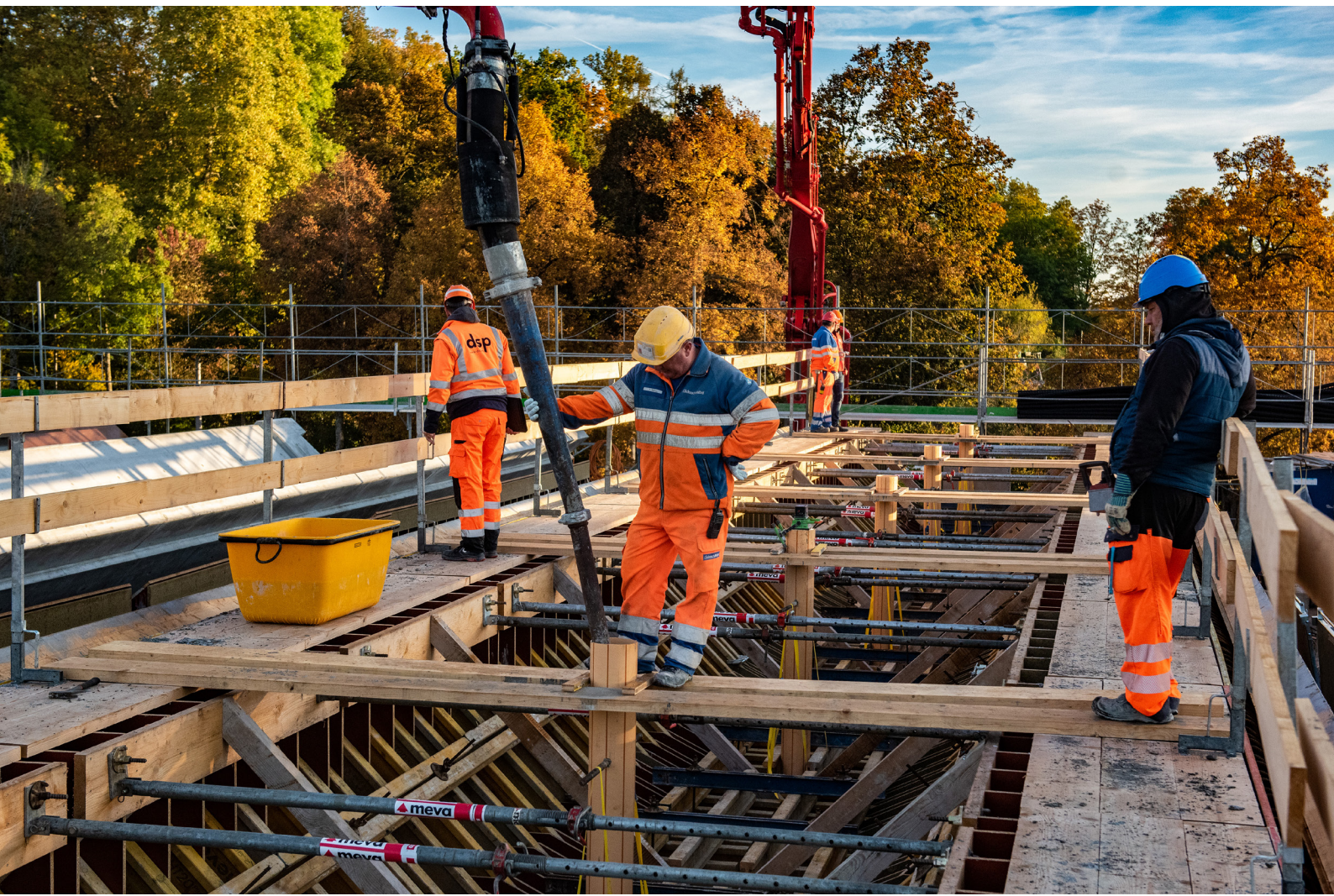
Bauarbeiten an der 50-Meter-Schwimmhalle
