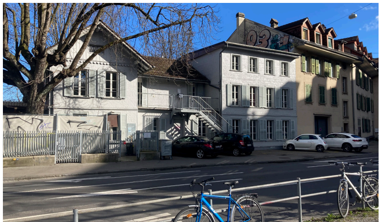
Bestand Drogenanlaufstelle Holderstrasse 22
