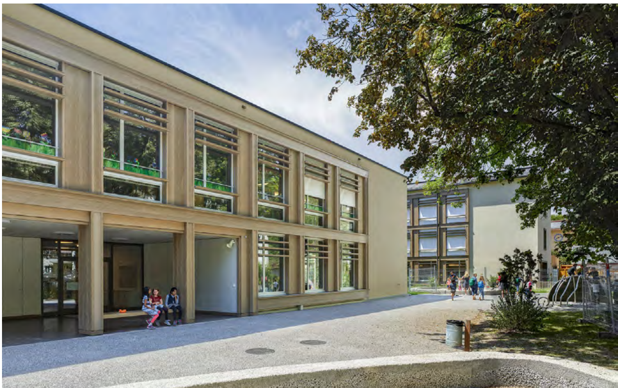
Basisstufe – Eingang und Pausenhalle
