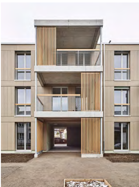
Ausschnitt Fassade Südwest
