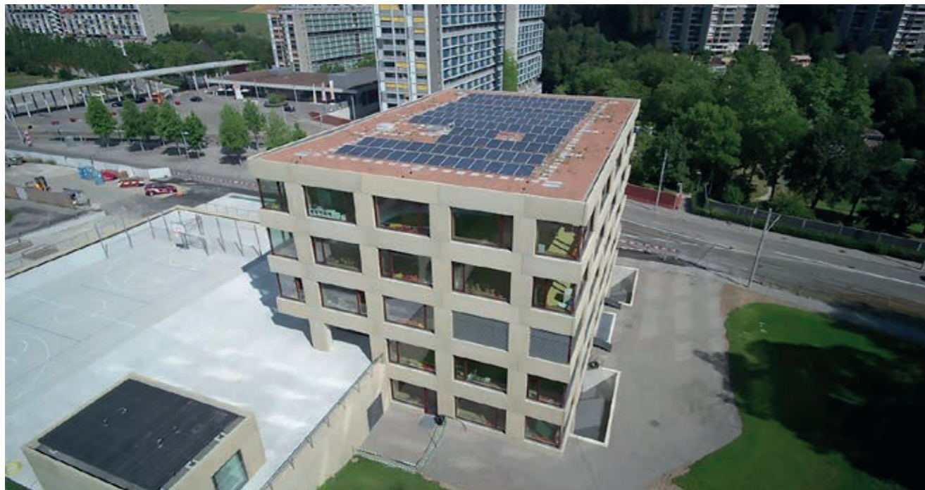
Photovoltaikanlage ewb – VS Brünen, Billeweg 5
