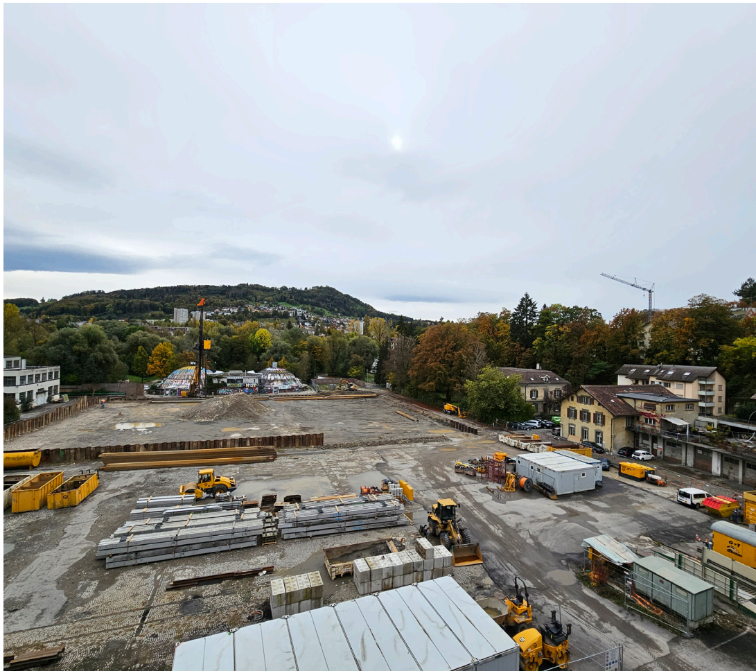
Abschlussarbeiten Altlastensanierung © ISB
