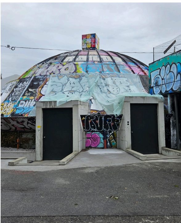
Sanierung der Notausgänge © ISB
