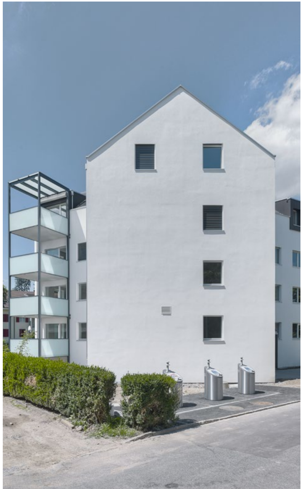
«Winterhäli»-Quartier, Bümpliz: Nach Abschluss der Renovationsarbeiten am 60-jährigen Mehrfamilienhaus an der Fröschmatt- und Zypressenstrasse wird im Kanton Bern die erste Sanierung mit dem Standard MINERGIE-P-ECO zertifiziert.
