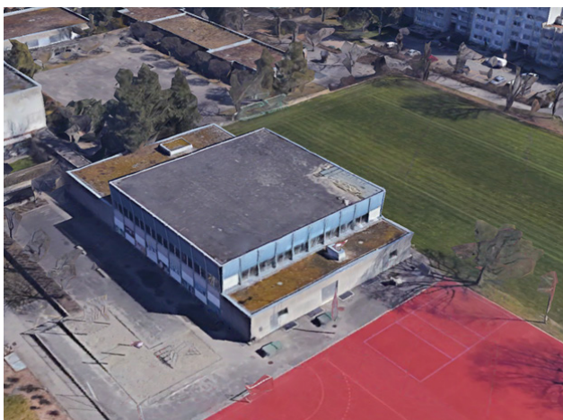
Zustand der Doppelturnhalle Frühjahr 2018
