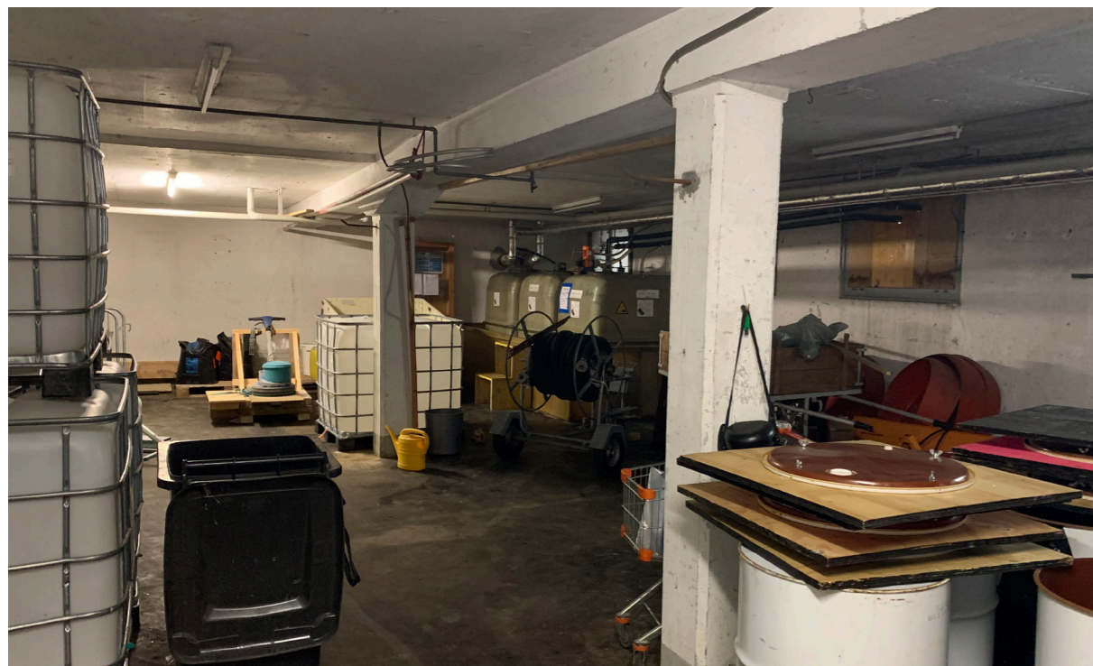
Untergeschoss Garderobengebäude Nord
