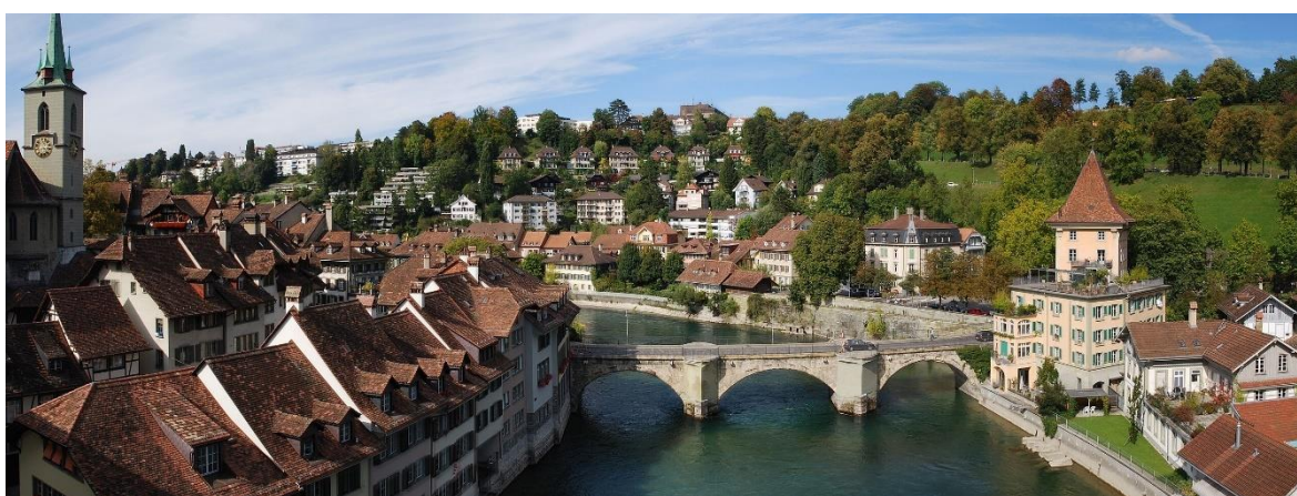
Abb. 1: Lage der Untertorbrücke
