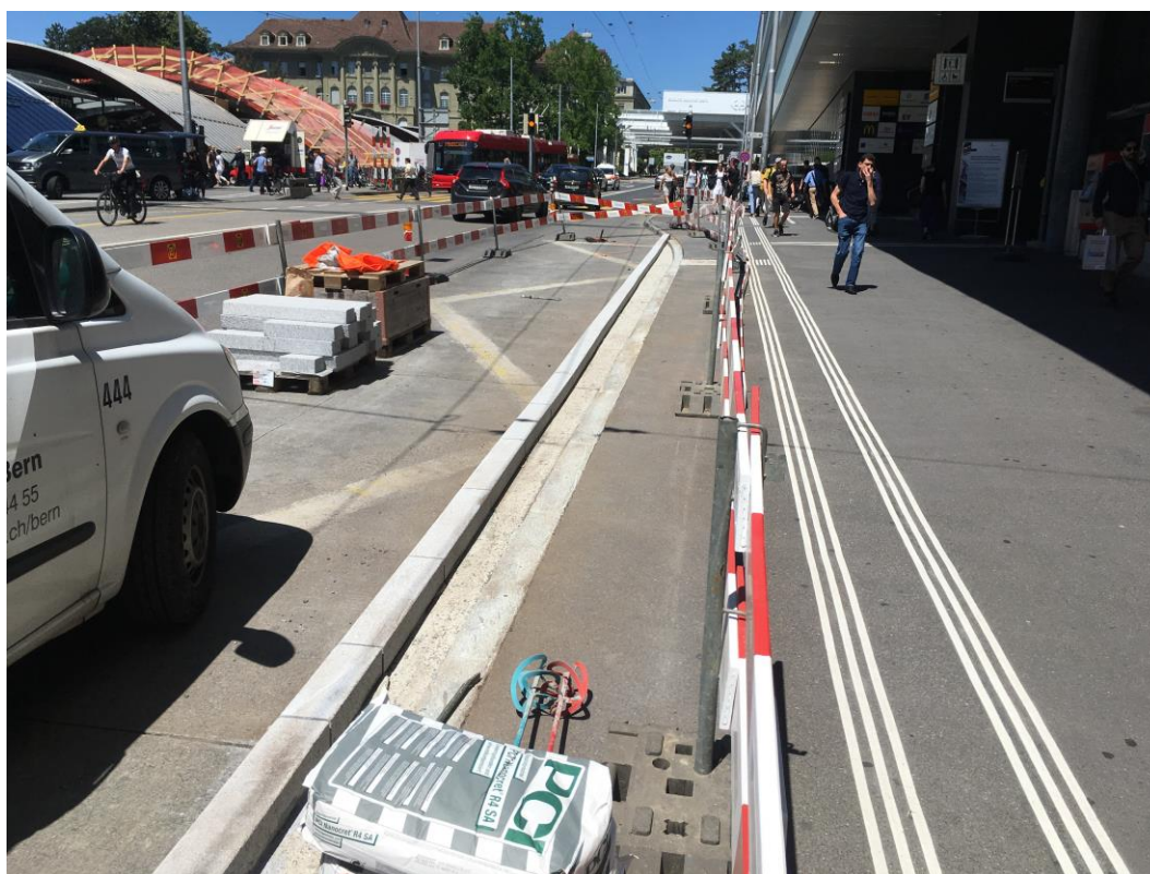
Provisorische Anpassung der Bushaltestelle Schanzenstrasse an die Erfordernisse der längeren Doppelgelenkbusse. Definitiv umgestaltet und den Vorgaben des BehiG angepasst wird die Haltestelle im Rahmen des Projekts ZBB.
